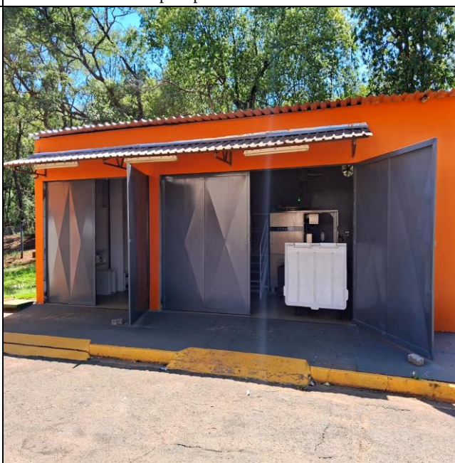
Figura 29 – Sala da máquina autoclavagem para tratamento dos resíduos hospitalares gerados e posterior coleta da empresa Cheiro Verde Ambiental que dará a destinação correta deste resíduo de interesse ambiental.
