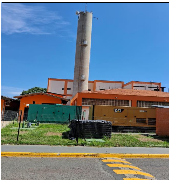
Figura 18 – Reservatórios de água potável existentes.
